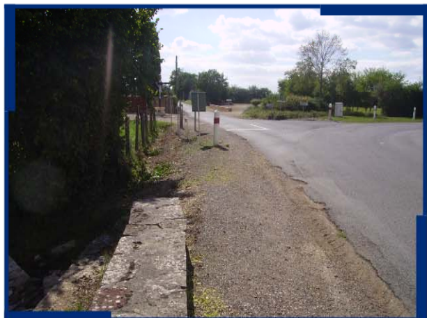
6 : "Ste-Soline" : limite de zone inondable rive gauche au droit du carrefour
