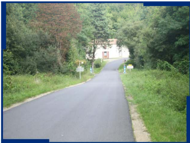
21 : "Payré" : limite de zone inondable rive droite devant la maison
