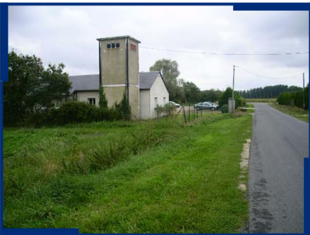
15 : "Razines" : limite de zone inondable rive gauche au pied du poteau électrique le long de l'ancienne laiterie
