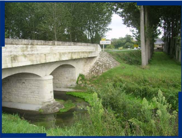
13 : "Jaulnay" : maison derrière les arbres en zone inondable et route en remblai
