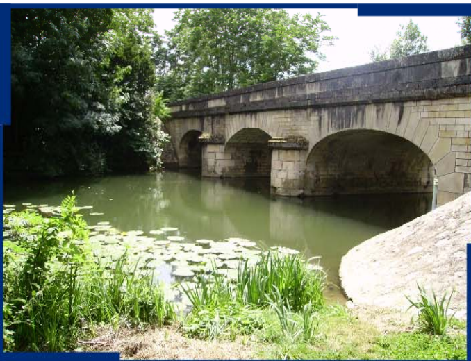
12 : "Béthines" : vue en aval de l'ouvrage du lit mineur du Salleron
