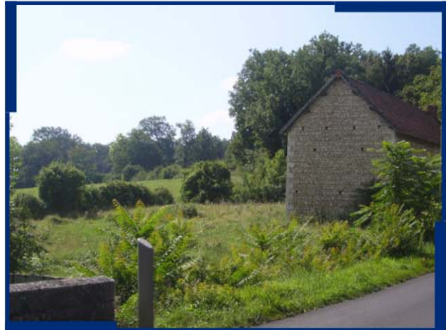
9 : "Pont du Tervanne" : maison en zone inondable
