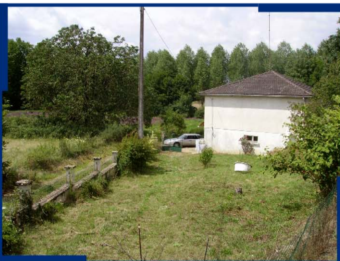
14 : "Béthines" : maison en zone inondable en rive droite en amont du pont
