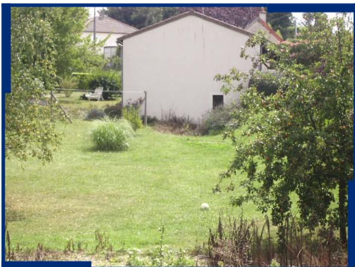
13 : "Béthines" : limite de zone inondable en aval du pont rive droite au pied de la maison
