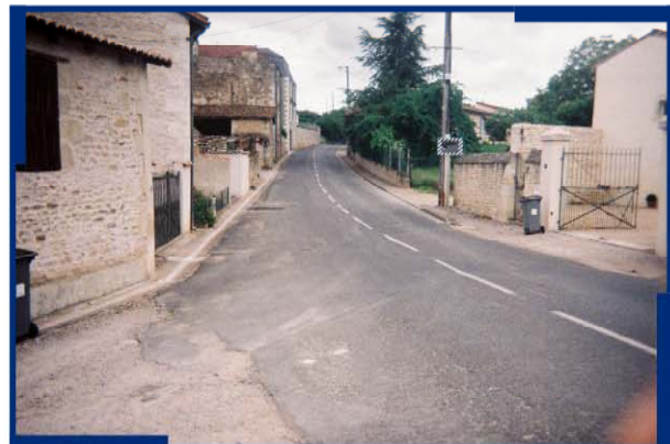
6 : " Le Moulin de Chapron" : limite de zone inondable en rive droite arrive au niveau du poteau électrique à droite de la route
