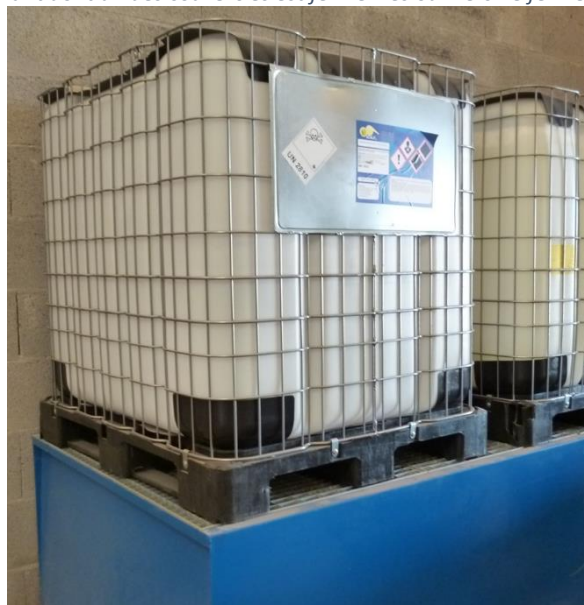
Photo 14 : Stockage des bidons de solvants sur rétention
