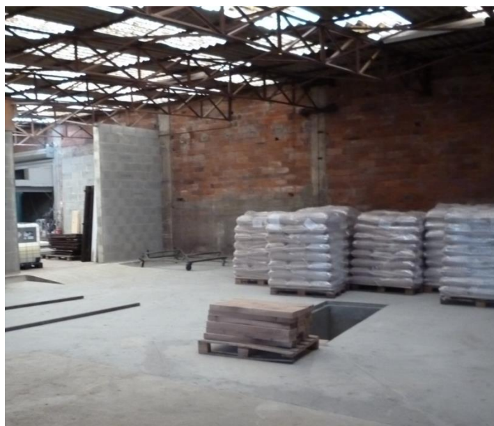
Photo 16 : Future pièce des solvants. Le béton a été posé sur la bâche étanche posée sur la photo précédente. On remarque que le niveau de la pièce est plus bas que celle de gauche.
