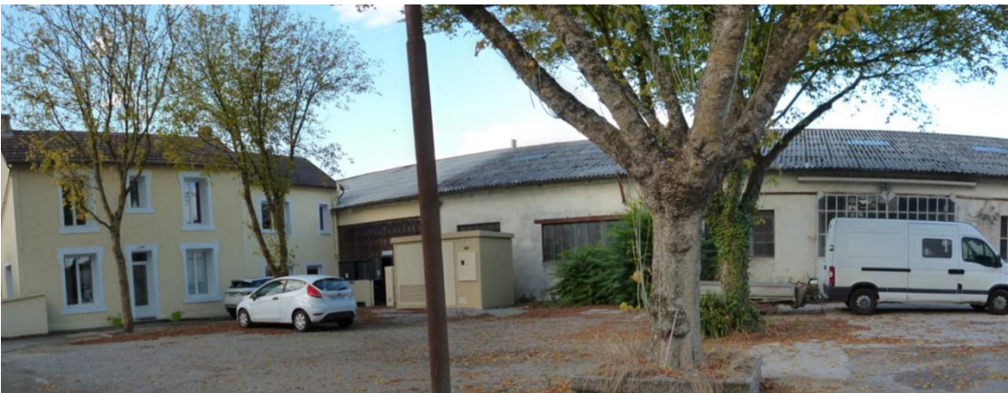
Photo 2 : L'accueil de Décap'Soft ainsi que les bureaux sont situés dans le bâtiment à gauche. La limite de la propriété de l'entreprise est environ au niveau du transformateur EDF.
