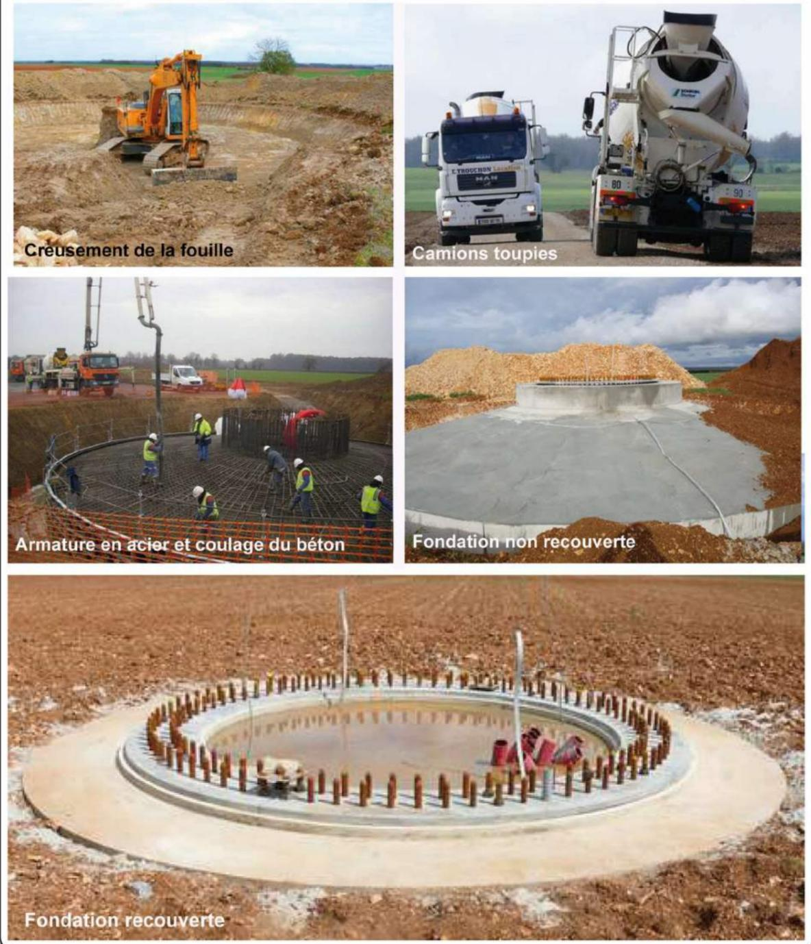
Photographie 78 : Etapes de réalisation d'une fondation d'éolienne
