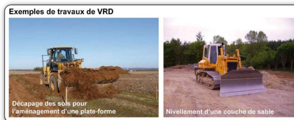
Photographie 77 : Exemples d'engins de travaux de VRD
