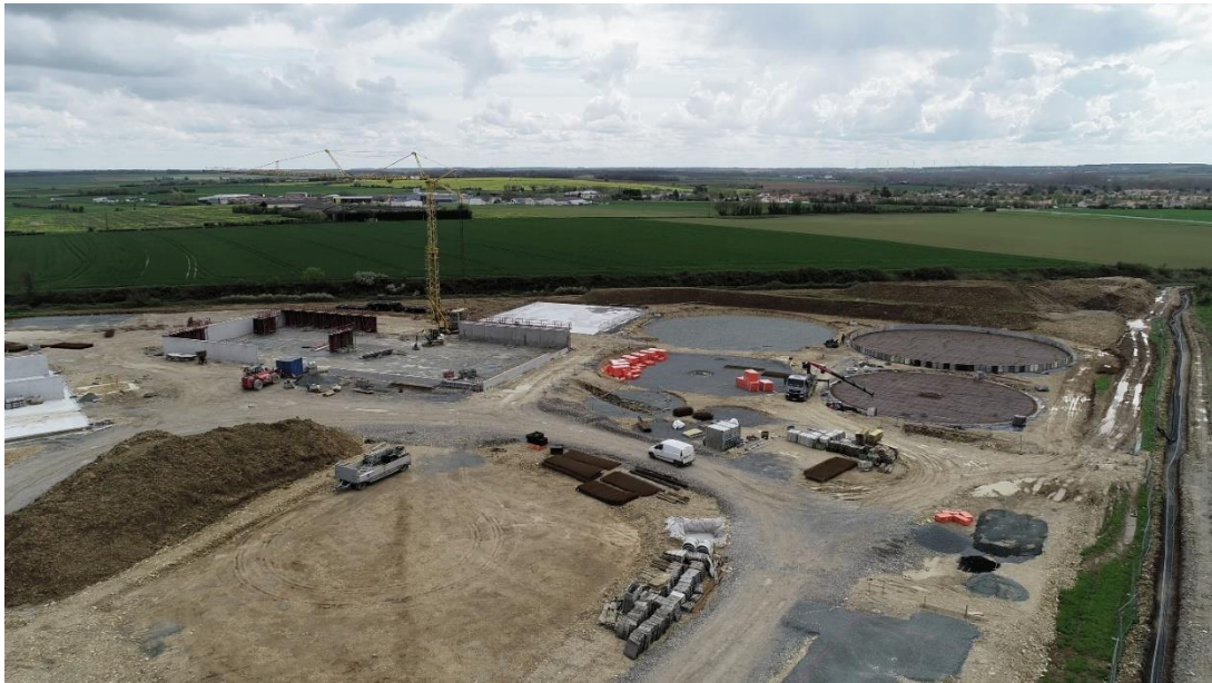
Figure 53 : Vue de la phase chantier d'un projet de même type ( https://www.demeter-energies.fr )
