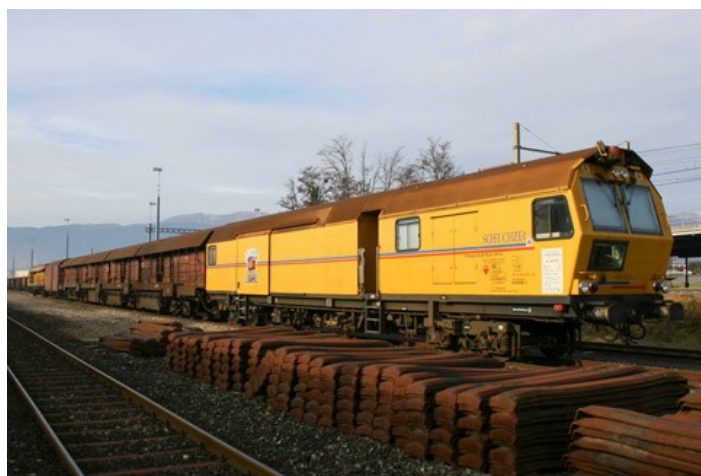
Train meuleur de rails (Scheuchzer S.A.)
