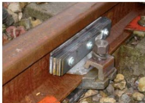
Exemples d'absorbeurs sur rail (Corus et Socitec)
