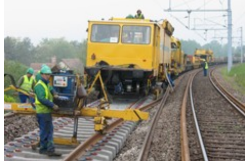
Longs Rails soudés sur traverses béton
