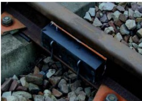
Exemples d'absorbeurs sur rail (Corus et Socitec)
