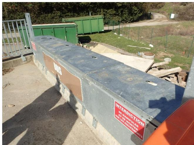
Figure 10 : dispositifs anti-chute actuellement en place en haut de quai
