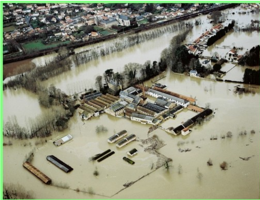
Illustration 10: Inondation du Clain en 1982 sur la commune de Ligugé (source : DDT86)
