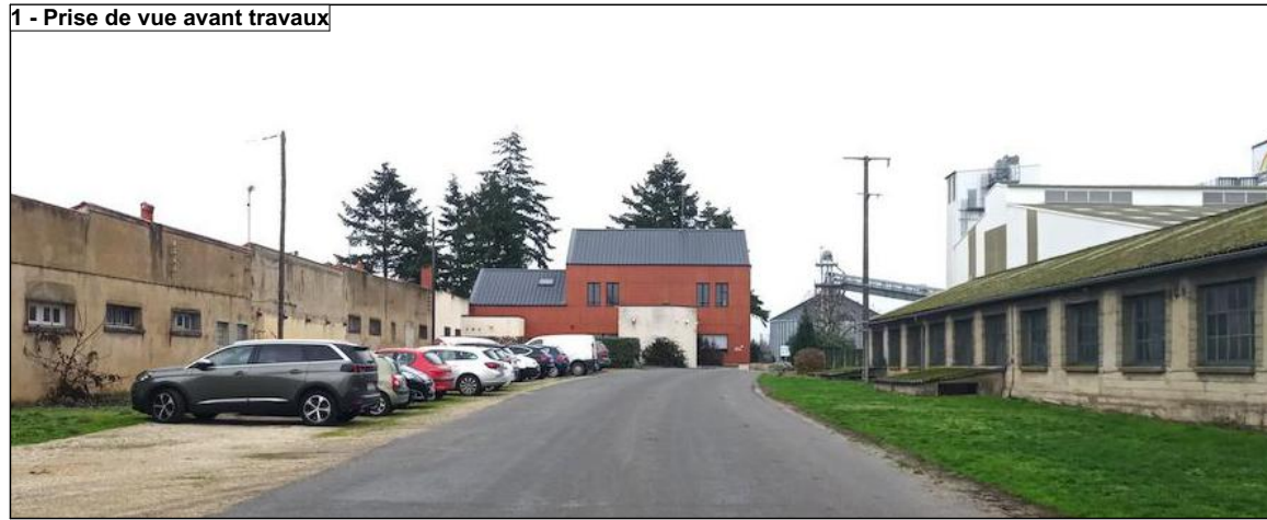
1 - Prise de vue avant travaux
