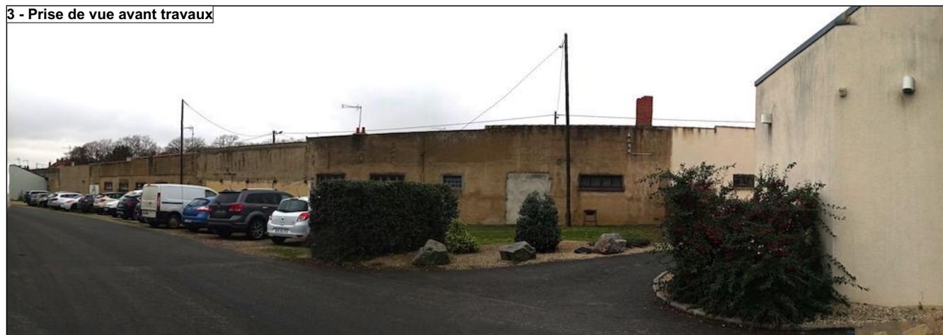
3 - Prise de vue avant travaux
