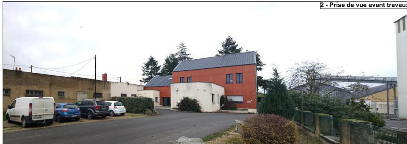
2 - Prise de vue avant travaux
