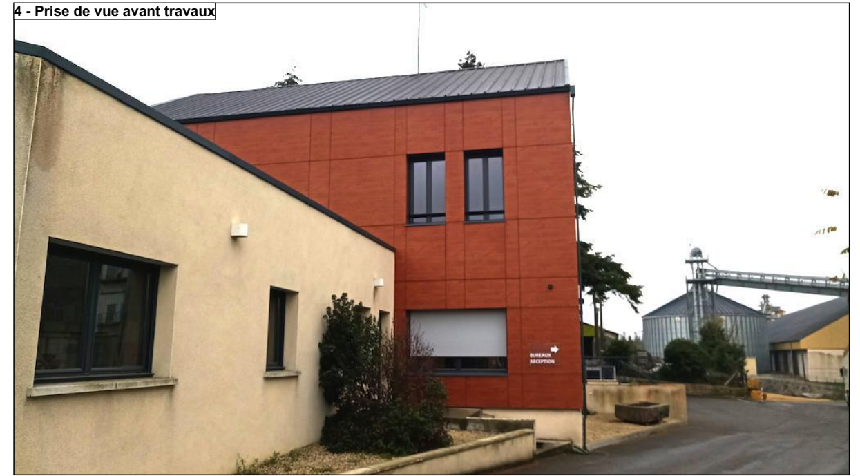
4 - Prise de vue avant travaux
