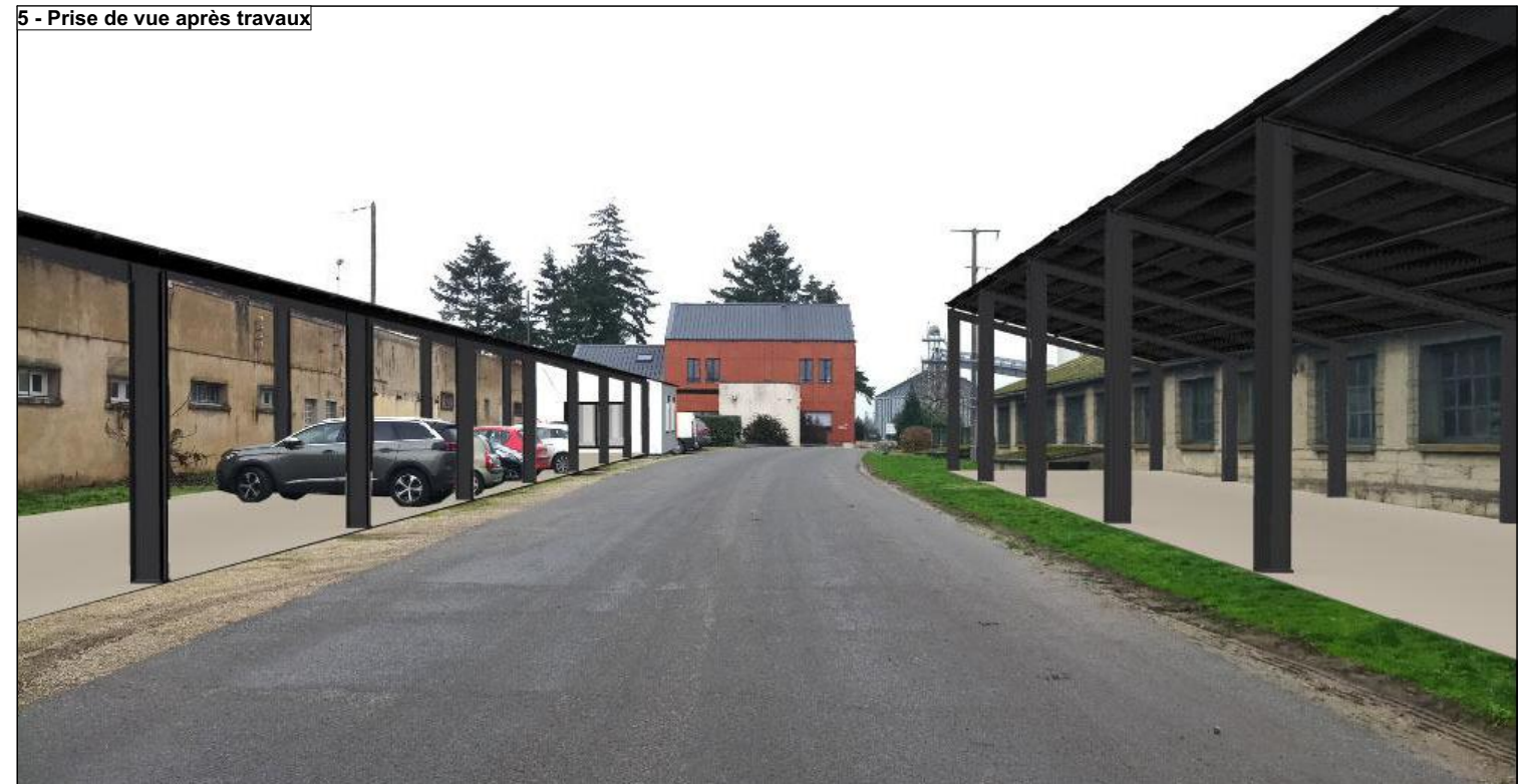
5 - Prise de vue après travaux
