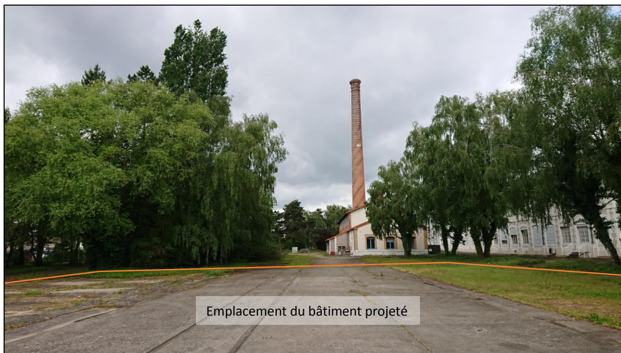
Figure 7 : Prise de vue de l'emplacement du bâtiment projeté (© Ahida Conseil, 28/04/2020)
