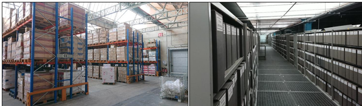
Figure 4 : Exemple de stockage d'archives en rack sur palette (à gauche, bâtiment 133) et dans des boîtes ignifugées sur étagères métalliques (à droite, bâtiment 132) (© Ahida Conseil, 28/04/2020)
