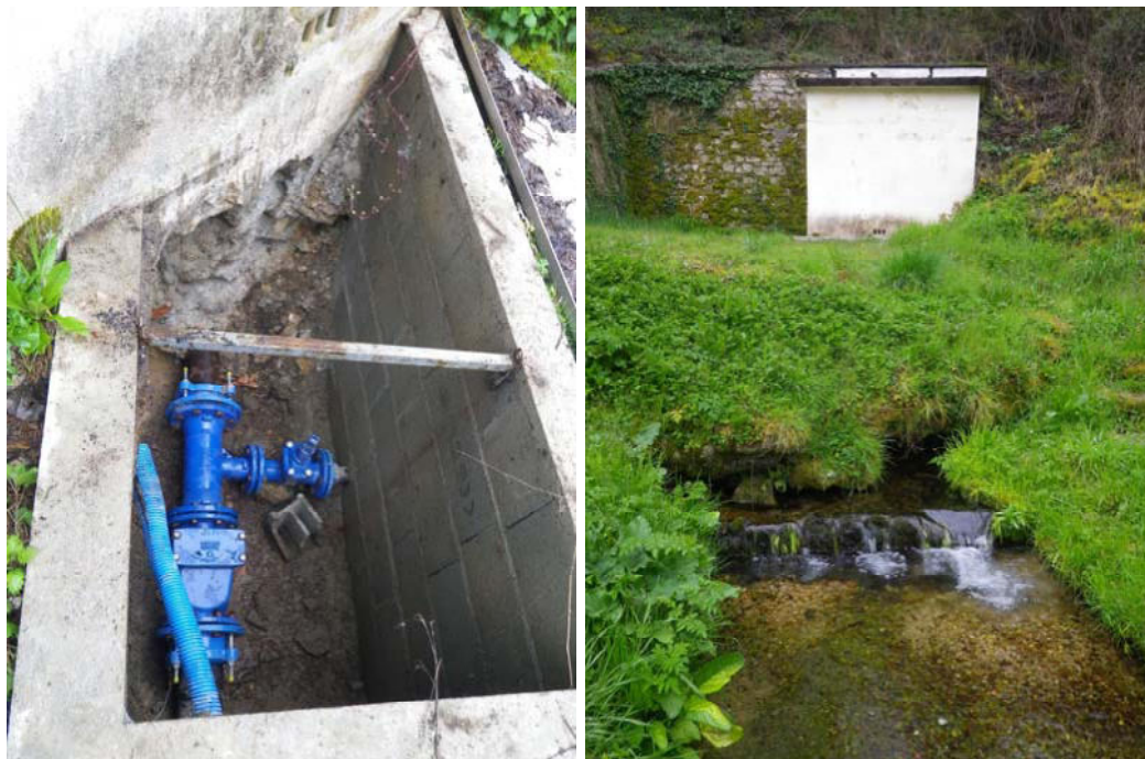
Figure 4 : exutoire de la source (photos)
