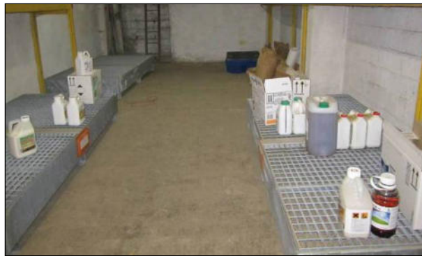
Figure 35 : local pour produits phytosanitaires, avec bac de rétention
