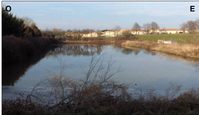
Figure 40 : premier bassin des anciennes lagunes de Maillé avant leur arrêt (28/02/2012)
