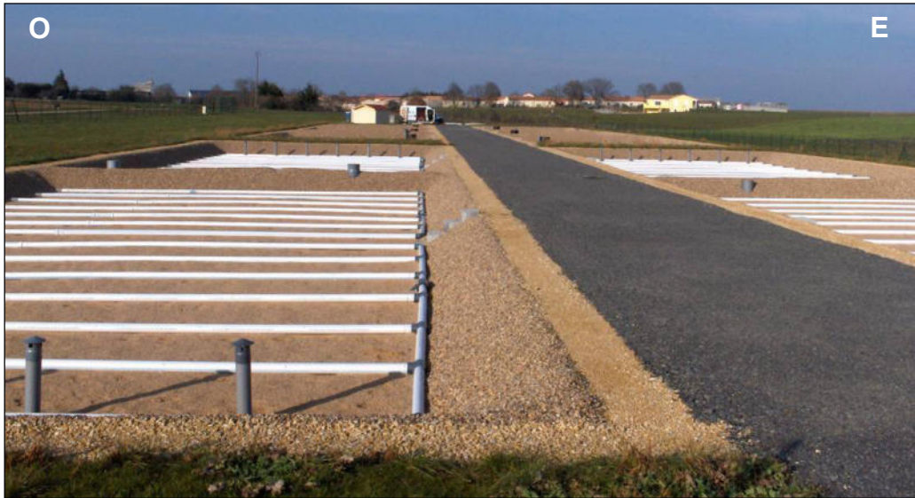
Figure 42 : nouvelle station d'épuration de Maillé (filtres plantés de roseaux) avant sa mise en service (28/02/2012)
