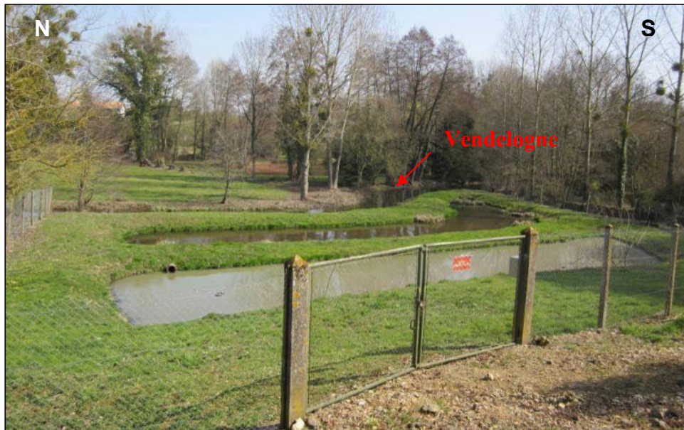
Figure 43 : lagunes de Civray-les-Essarts
