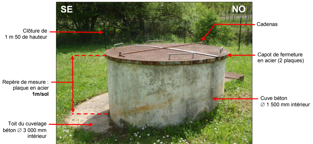
Figure 18 : description de la tête de captage
