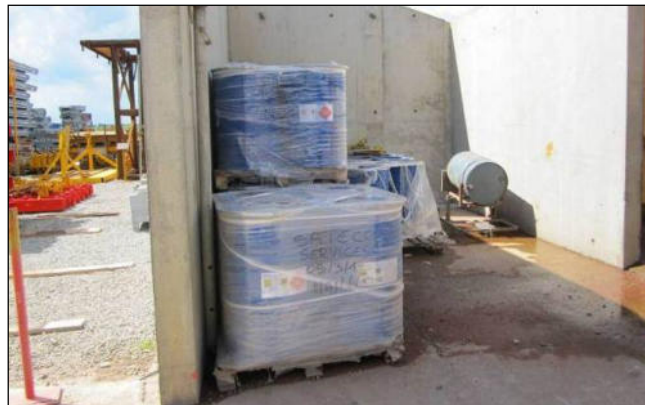
Figure 31 : stockage des fûts de peinture en extérieur
