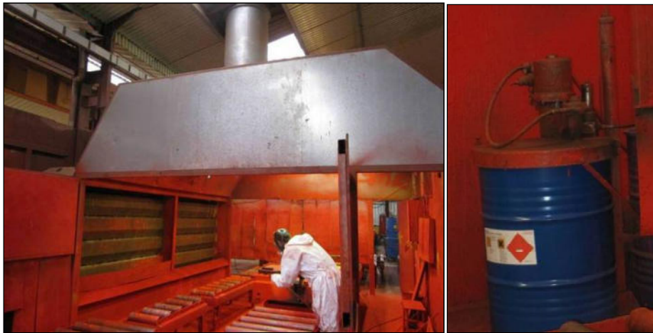
Figure 30 : cabine de peinture à rideau d'eau avec prélèvement dans le fût de peinture
