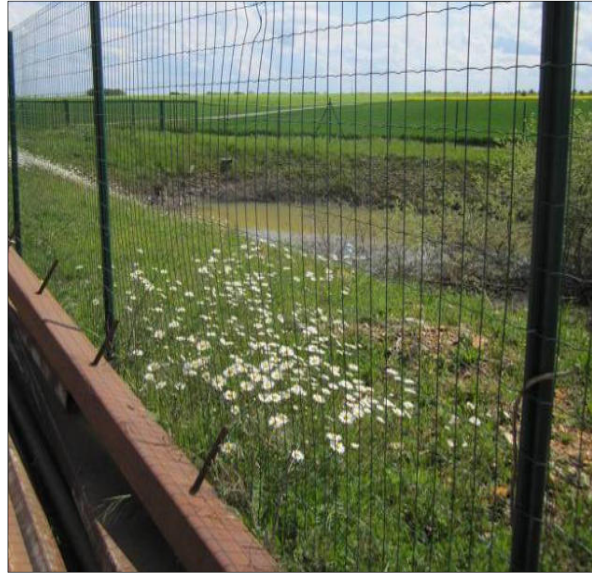
Figure 29 : bassin d'infiltration pour les eaux industrielles
