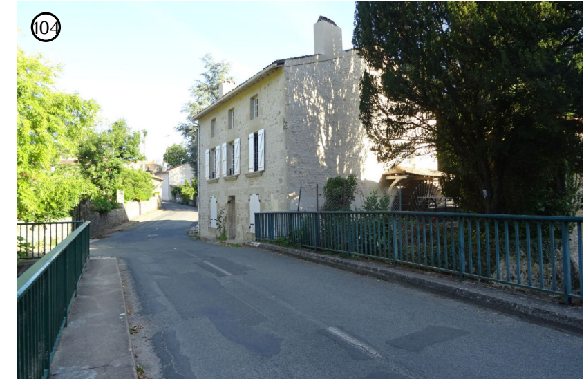
104 Le coeur historique de Vouneuil-sous-Biard est construit en partie sur les rives de la vallée de la Boivre
