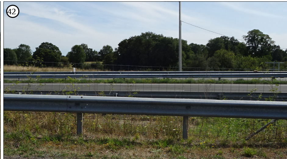
42 A proximité de l'autoroute A10 les glissières de sécurité se généralisent
