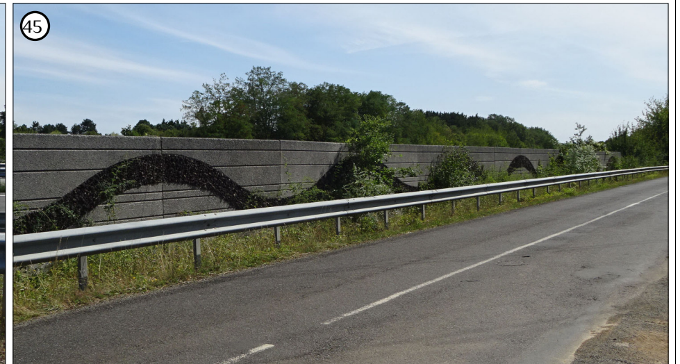
45 Ici, les glissières sont associées à un mur anti-bruit en raison de la proximité d'un lotissement
