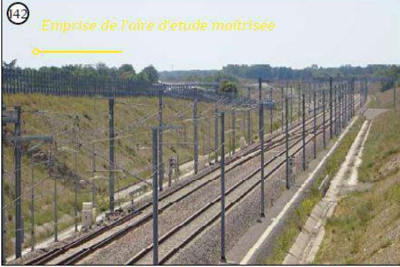
La voie LGV est observable depuis les franchissements routiers. Sur l'essentiel du linéaire concerné par les aires d'étude elle est encaissée et circule entre deux hauts talus. La zone de l'emprise maîtrisée n'est pas visible
