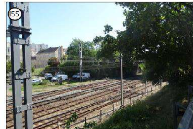
155 Infrastructures de la gare de Poitiers
