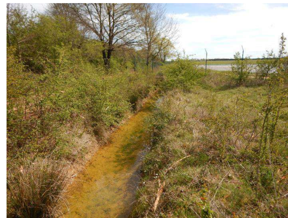
Figure 97 : Vue sur le fossé et le bassin de rétention en arrière-plan
