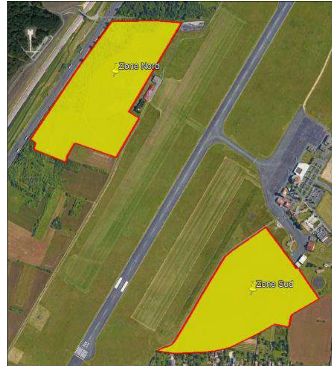
Figure 73 : Carte de situation des zones du projet par rapport à la bande de piste de l'aéroport de Poitiers-Biard (Source : EDF Renouvelables)
