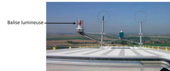
Figure 26: Système de balisage lumineux (Source : ECOTERA)
