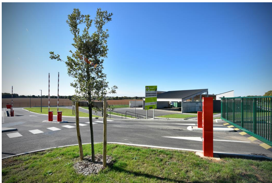
Figure 17 : Vue du portail d'entrée de la déchèterie
