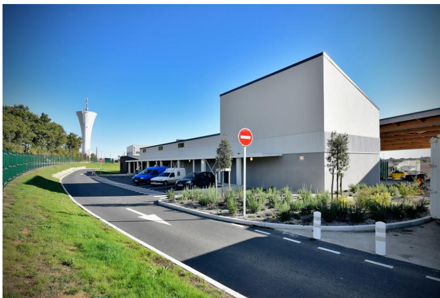
Figure 11 : Vue depuis le fond sur le local d'accueil, les locaux DDS et réemploi
