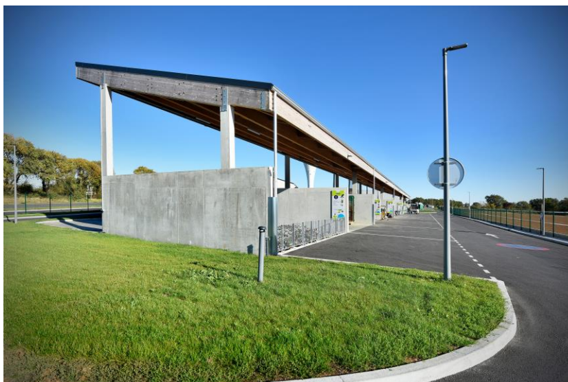
Figure 14 : Vue des alvéoles de déchets couvertes, séparées par des murs bétons et filet anti-envols côté exploitation
