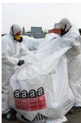
Figure 9 : Exemple de conditionnement des déchets d'amiante lié
