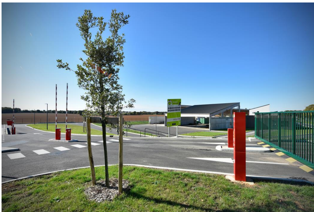
Figure 4 : Entrée du site avec un panneau d'information
