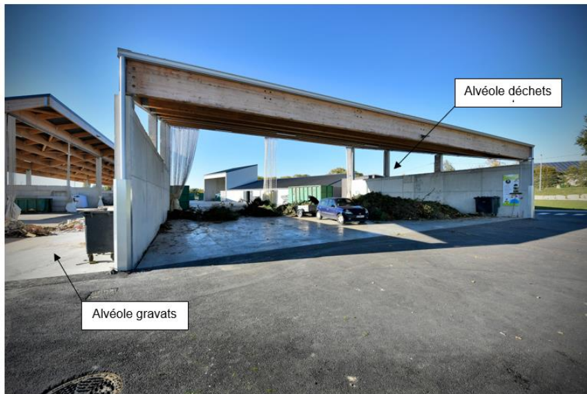
Figure 5 : Premier pôle sur la déchèterie
