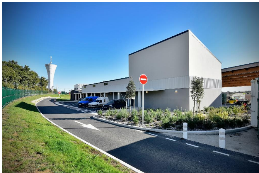
Figure 6 : Deuxième pôle de dépôt sur la déchèterie
