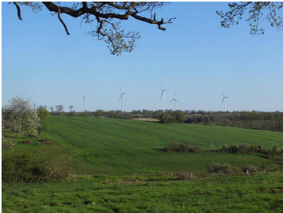
Figure 4. Parc éolien d'Adriers Energies
