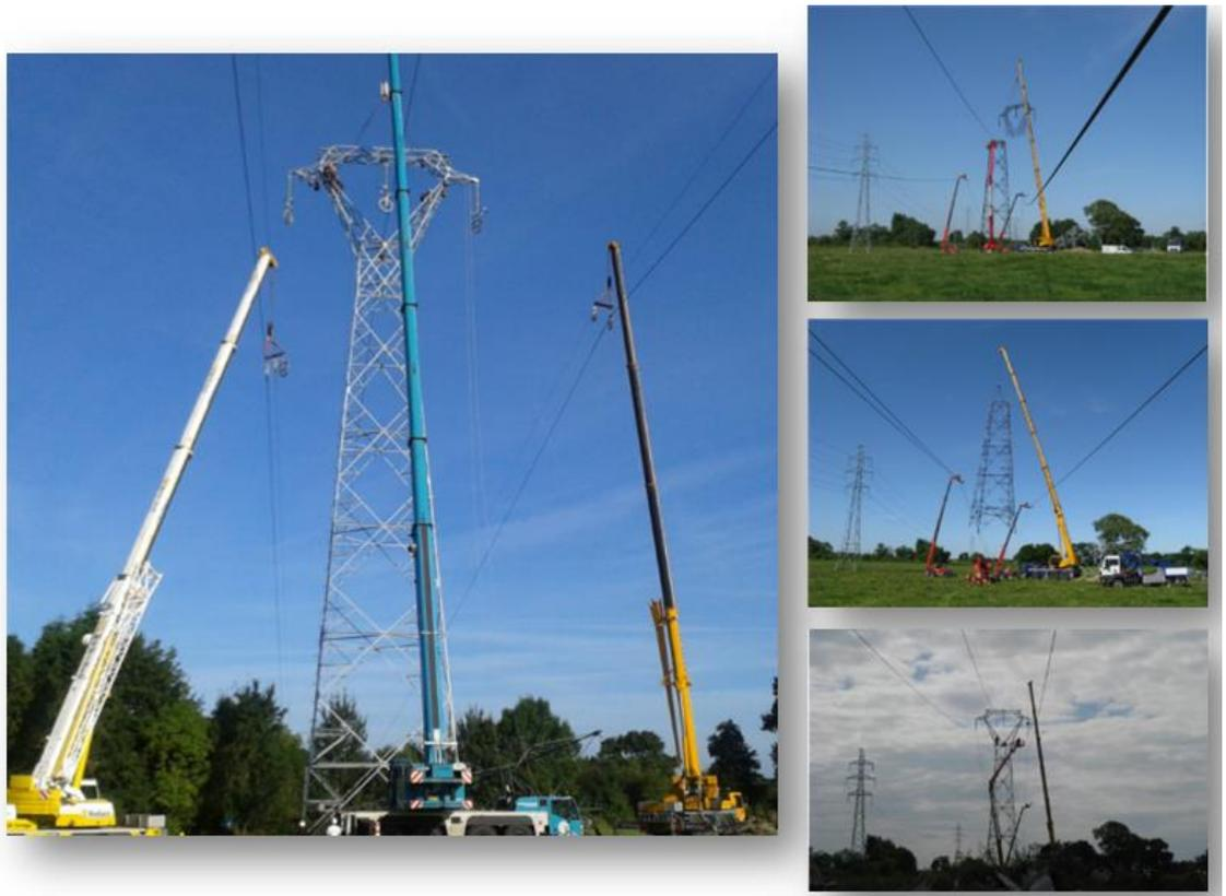
4<sup>ème</sup> étape : déroulage de la nouvelle liaison électrique entre le support n° 94 et le portique du poste LE CHARRAUT. Les câbles électriques sont de type AZALEE 177.
