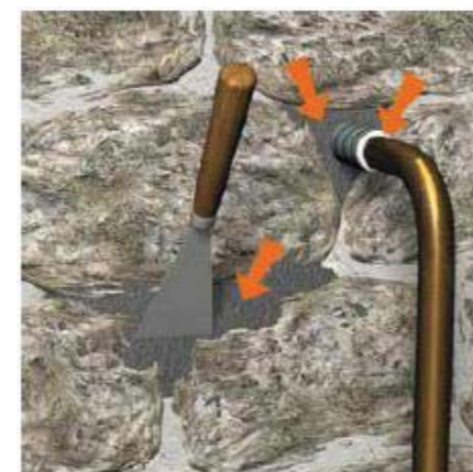
Colmatage d'un mur pour empêcher l'eau de pénétrer dans votre habitation.
