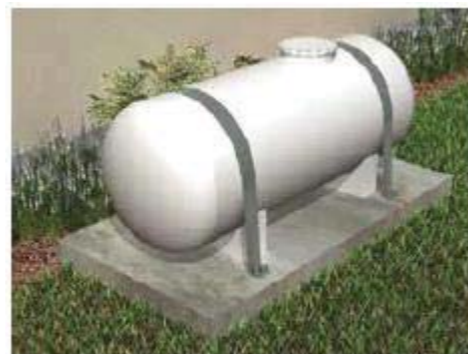
Tous les objets situés à l'extérieur doivent être fixés (ici une cuve de stockage).
