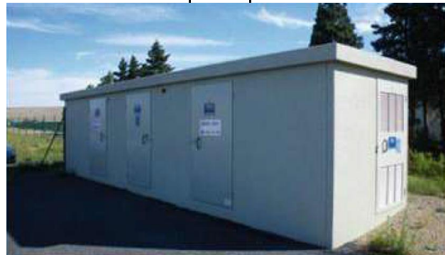
Illustration 14 : Exemple de poste de transformation
