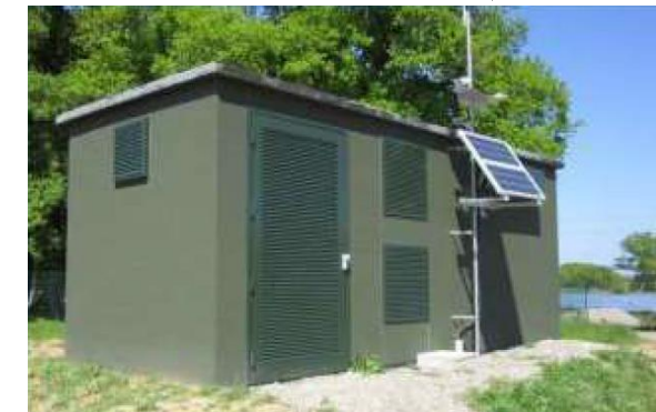
Illustration 15 : Poste de livraison
